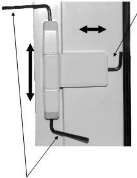
Stufenlose Höhenverstellung: Ziernippel entfernen und mit einem Im- busschlüssel SW 5, die gewünschte Höhenregulierung vornehmen. Durch lösen der oberen Schraube, kann mit der unteren Schraube die Höhe ver- stellt werden. Eine Umdrehung = 1 mm Veränderung
